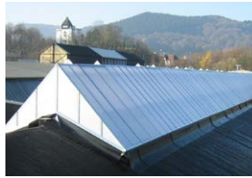
Sattellichtband nach der Sanierung
